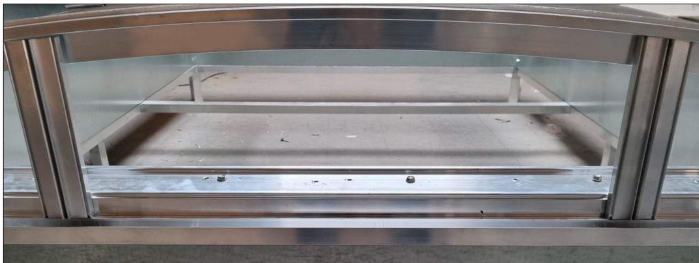
Kuva 7. Esimerkki päädyn pystytukiprofiilien asennuksesta.
