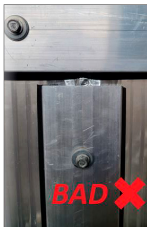
Kuva 16. Oikein ja väärin asennetut lasituslistat.
