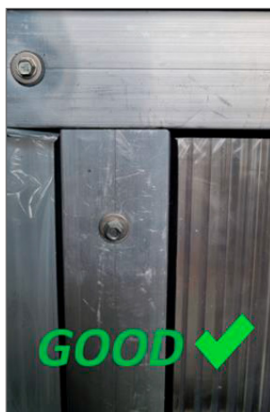
Kuva 16. Oikein ja väärin asennetut lasituslistat.
