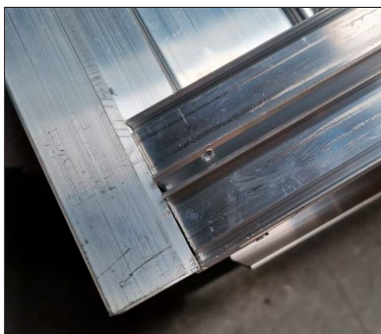
Kuvat 5 ja 6. Kaarevan tukiprofiilin kiinnitys.
