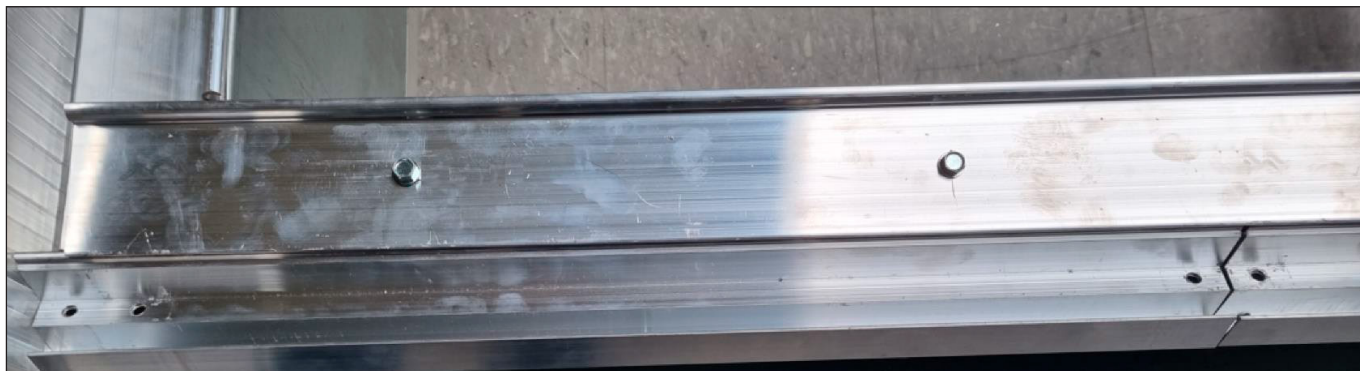
Kuva 4. Oikein asennetut nivelliitos- ja kiinnitysprofiili.
